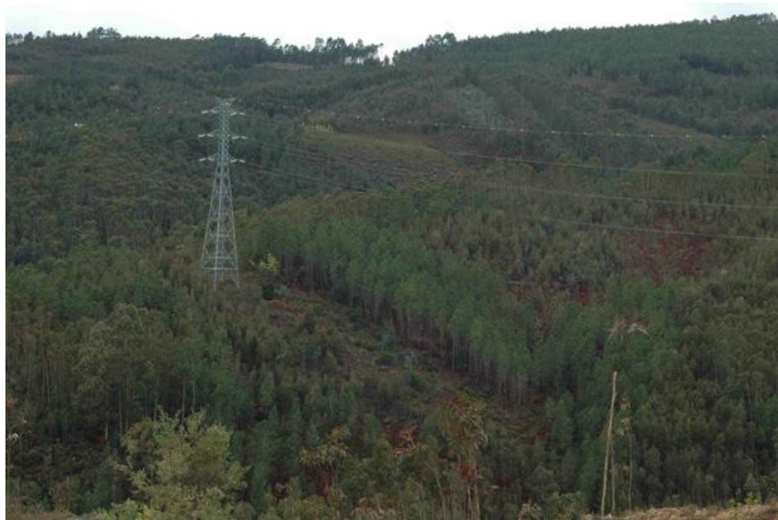
FOTOGRAFIA 4.5 – Vista geral do troço 3. Zona de matos baixos e vegetação arbustiva pouco densa na proximidade do apoio (troço facilmente prospectável), seguido de uma parte de vale muito denso, com socacos e de progressão muito difícil (troço 3, apoio 70)
